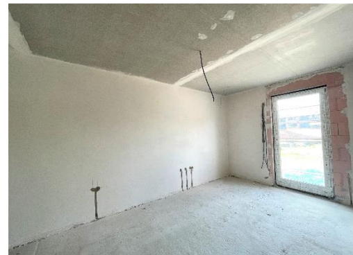
Blick nach Innen: Küche mit eingesetztem Fenster
