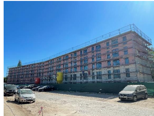
Haus 11 – Ansicht von der Einfahrt aus
