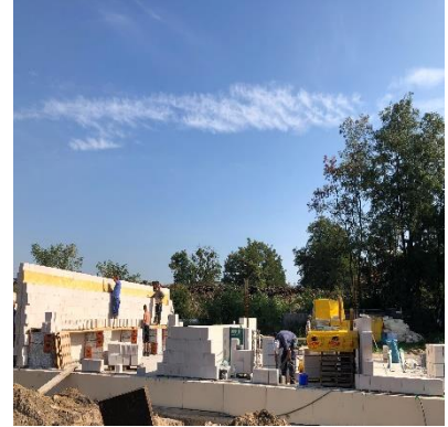
Haus 11 – Maurerarbeiten Bauteil 2
