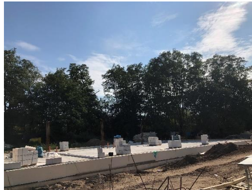
Haus 11 – Bodenplatte Bauteil 2
